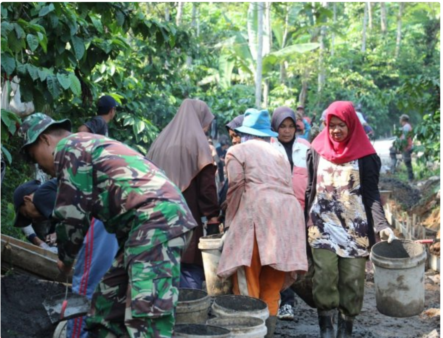
Ibu Ibu Bantu Percepat Pembangunan TMMD
